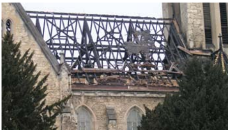
Nach dem Brand von 2007 musste der Dachstuhl quasi neu aufgebaut werden. Die Gestaltung und Ausführung geschah nach Befund.
