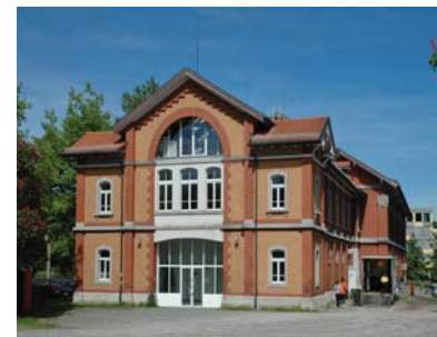
Die 1889 durch Stadtbaumeister Theodor Gohl erstellte Reithalle erhielt ihr rotes Backsteinkleid wahrscheinlich in Anlehnung an das 1885 nebenan wiederaufgebaute Magazingebäude.
