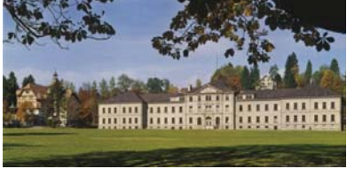
Die Kaserne St.Gallen kurz vor dem Abbruch 1980. Sammlung Uhler.
