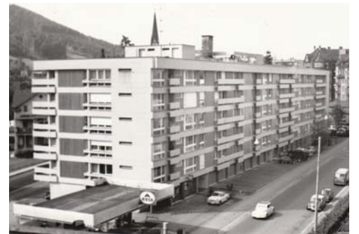
Nach dem Abbruch der Sägereigebäude entstand das sechsgeschossige Mehrfamilienhaus nach einem Entwurf von Willi Schuchter. Quartierverein St.Otmar.
