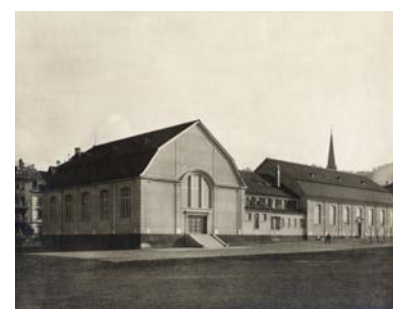
Die Turnhalle Kreuzbleiche, erbaut 1912/13 war eine der ersten Hallen für den Breitensport in der Schweiz. Im niedrigen Gebäudeteil befanden sich öffentliche Bäder. Baudokumentation.
