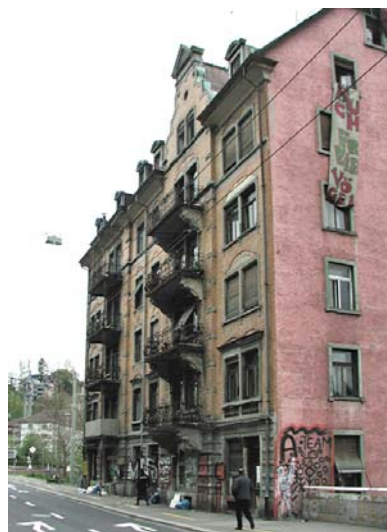
Für den Bau des "St.Leopards" wurden 2002 zwei Blockrandbauten an der St.Leonhard-Str. 74/76 abgerissen. Sie bildeten mit dem Ensemble vis-à-vis eine wichtige städtebauliche "Zange".
