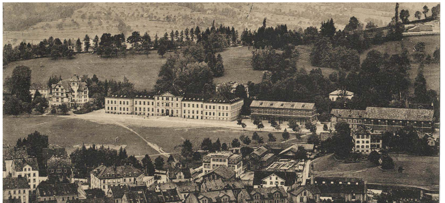
Aufgereiht an der Militärstrasse von links nach rechts: Kantine, Militärkaserne, Magazin und Reithalle. Im Vordergrund ist das Hotel St.Leonhard mit der Gartenhalle erkennbar, rechts davon das Lustgartenareal. Postkarte, 1916 abgestempelt. Sammlung Uhler.
