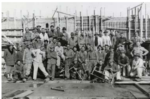
Aufnahme von der Baustelle des Fabrikareals der Bischoff Textil. In den 1950er Jahren waren Hochhäuser in der Schweiz dünn gesät, die grosse Entwicklung vollzog sich erst in den 1960er Jahren. Archiv Bischoff Textil.
