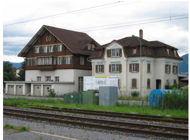
Abb. 23: Gächter, Holzbau. Wohnhaus auf Stickfabrik, rechts Labonté-Villa. Aufnahme vor dem Abbruch 2004.
